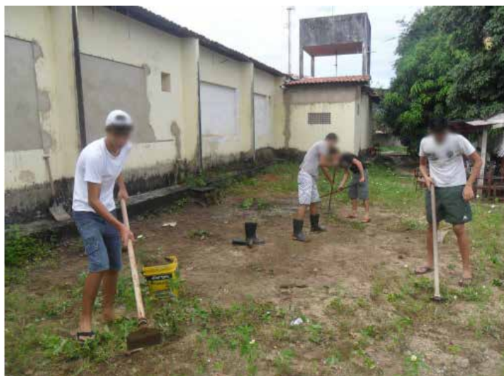
Figura 02 - Limpeza do terreno.
